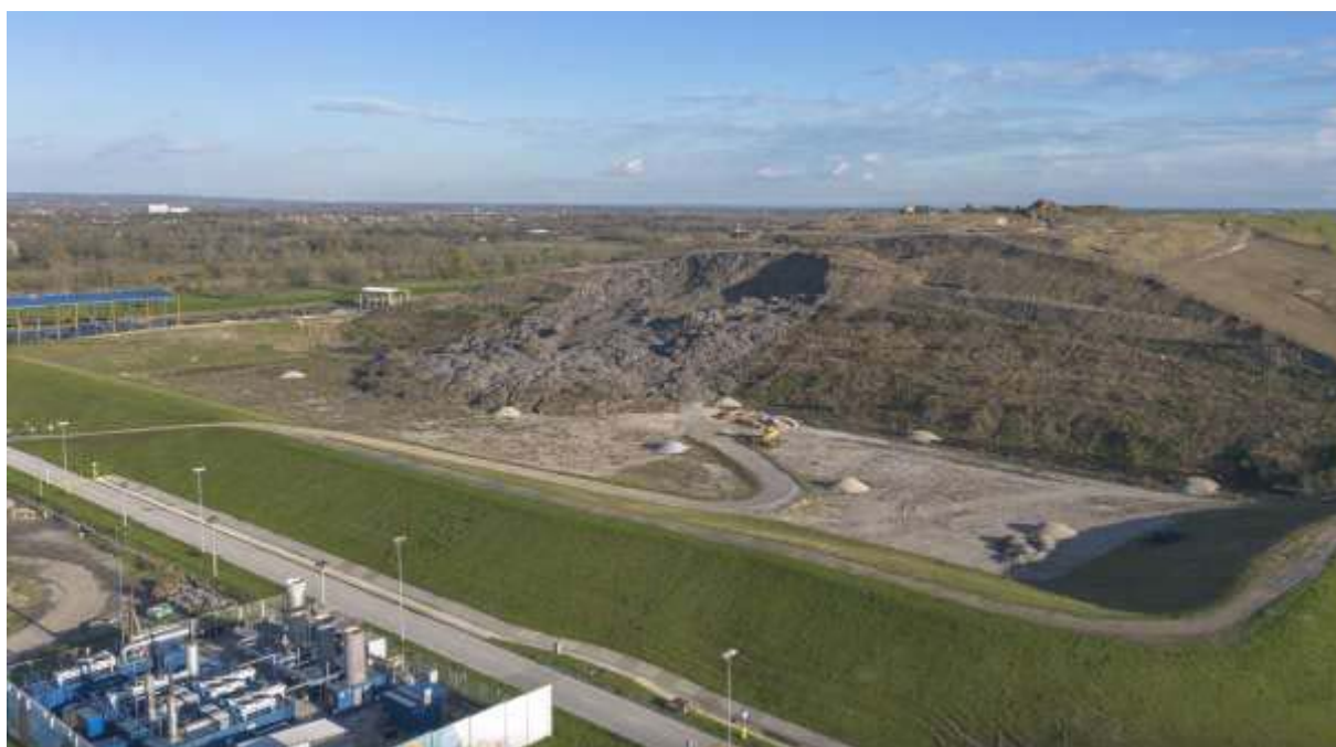
Slika 3. Pogled na odron zapad – PRVI odron 11.11.2023. godine – čeonni dio radne plohe 6/2, odlagalište Prudinec-Jakuševac
