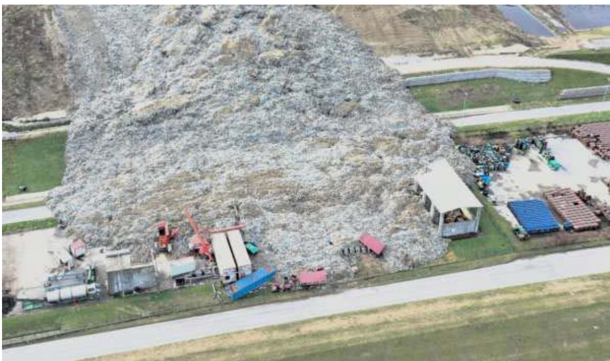
Slika 9. Pogled na odron sjever – DRUGI odron 04.12.2023. – bočni dio na odlagalištu Prudinec-Jakuševac
