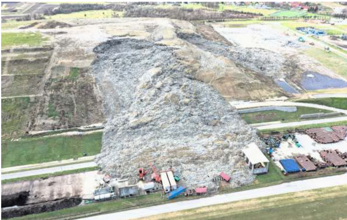
Slika 8. Pogled na odron sjever – DRUGI odron 04.12.2023. – bočni dio na odlagalištu Prudinec-Jakuševac
