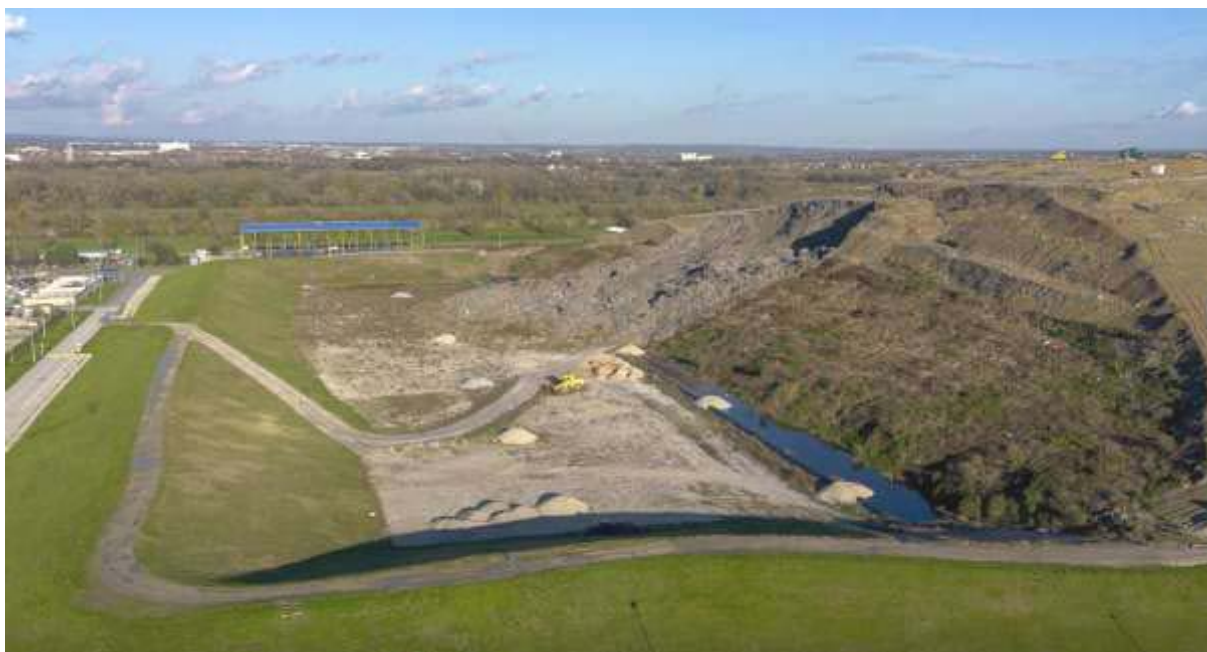
Slika 2. Pogled na odron zapad – PRVI odron 11.11.2023. – čeonni dio radne plohe 6/2, odlagalište Prudinec-Jakuševac
