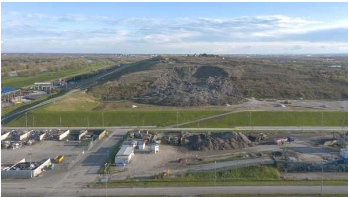
Slika 4. Pogled na odron zapad – PRVI odron 11.11.2023. godine – čeonu dio radne plohe 6/2, odlagalište Prudinec-Jakuševac
