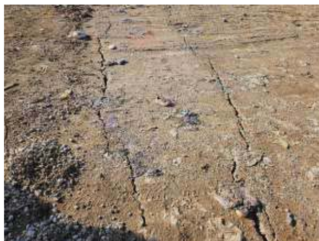
Pukotine na zaravnom vršnom dijelu odlagališta ploha 6/2 , širine pukotina iznose do 10 cm
