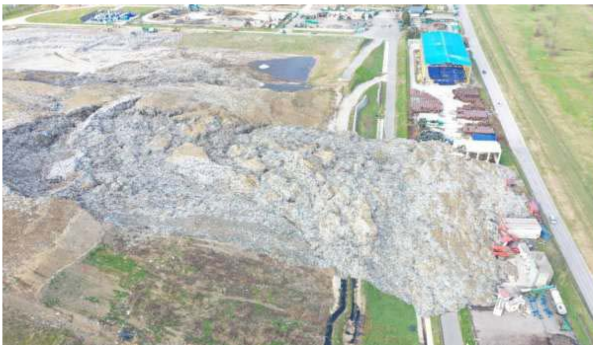
Slika 6. Pogled na odron sjever – DRUGI odron 4.12.2023. – ploha 6/2, odlagalište Prudinec-Jakuševac
