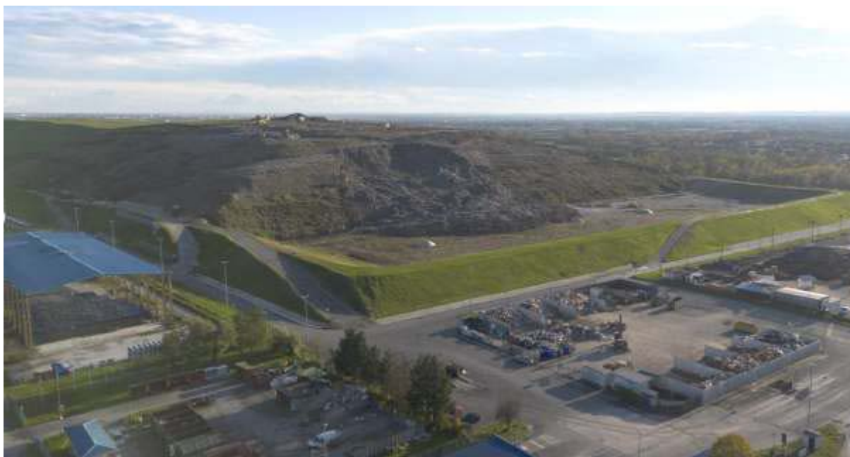
Slika 5. Pogled na odron zapad – PRVI odron 11.11.2023. godine – čeonu dio radne plohe 6/2, odlagalište Prudinec-Jakuševac
