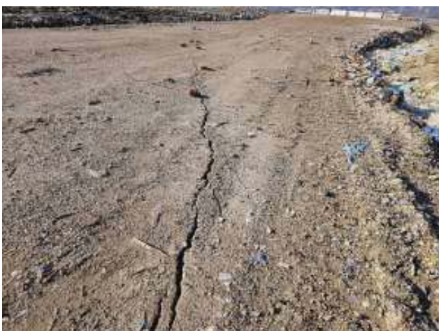
Pukotine na zaravnom vršnom dijelu odlagališta ploha 6/2 , širine pukotina iznose do 10 cm
